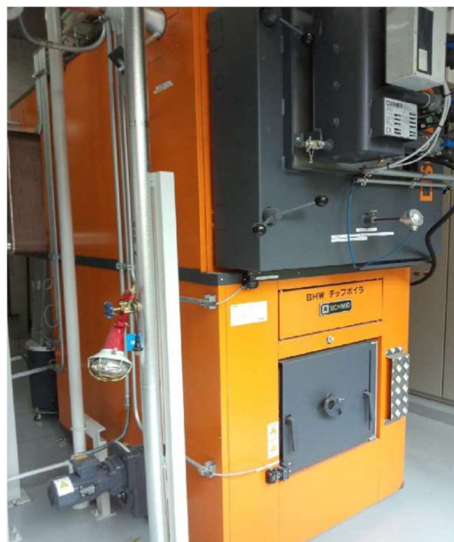
高原の宿氷太くんの チップボイラー (150kW)
