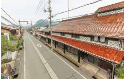
若桜町伝統的建造物群保存地区
