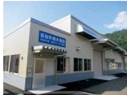
若桜町精米施設
