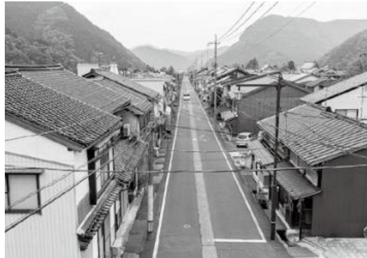
▲直線道路と隣が接した建物
