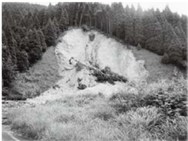
▲中原（加地）地内 山林斜面崩壊
