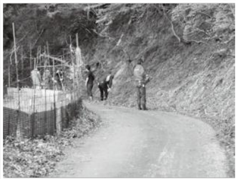
▲水路整備の様子
