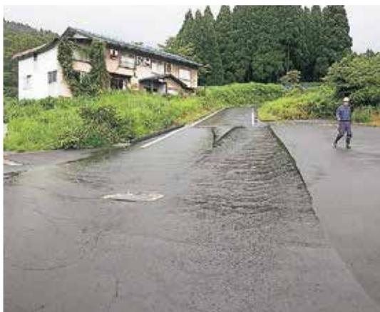
▲舗装工事完成後の流水試験の様子
