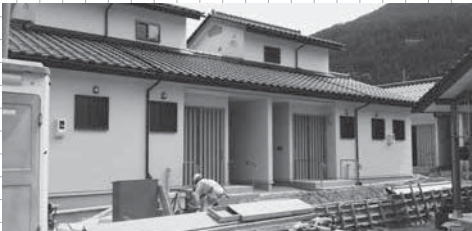
▲建築中の若葉団地の公営住宅
