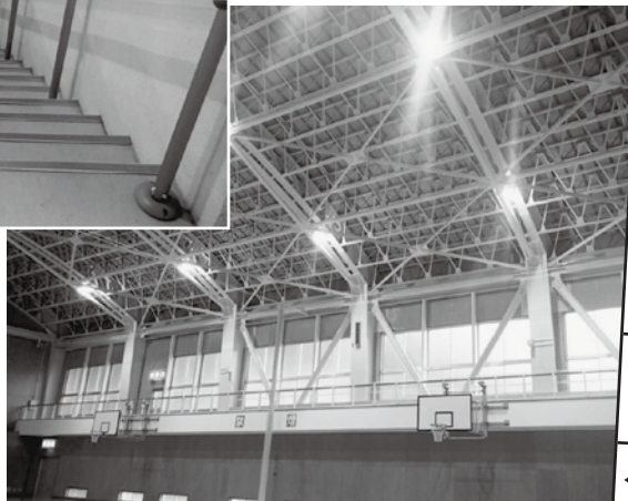
▲耐震補強工事により追加した鉄骨の様子
