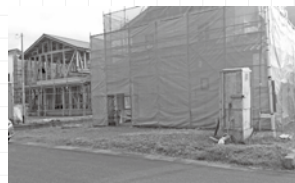
▲建設中の若者住宅
