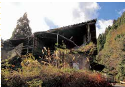
▲略式代執行により解体した空家
