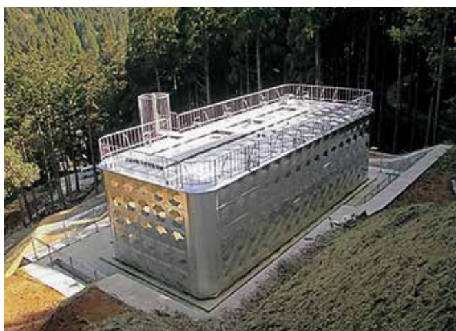
▲若桜地区：新配水池
