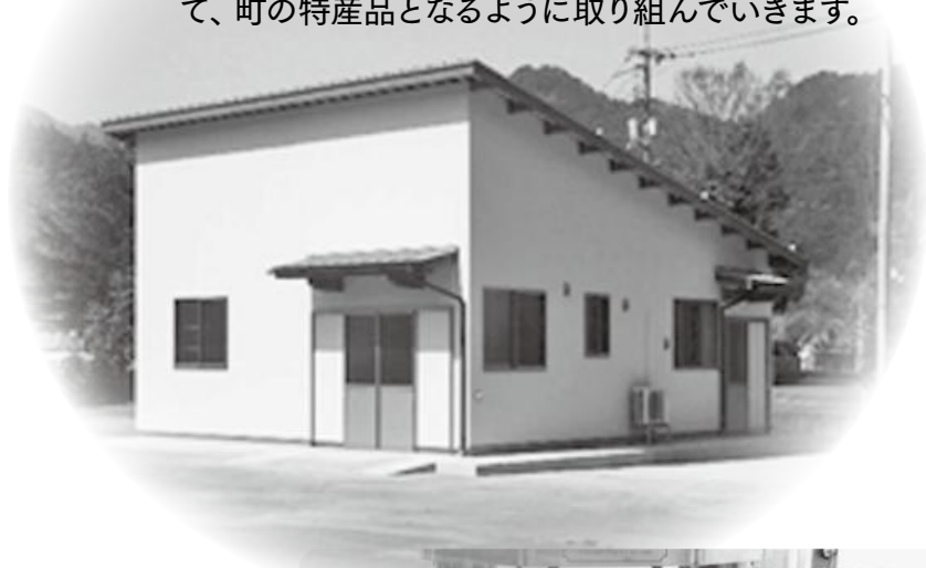
◀ 若桜町エゴマ搾油加工施設 「若桜エゴマ工房」
