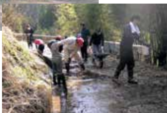
水路の泥上げ作業▶
