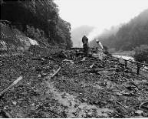
▲平成30年7月豪雨 瀧見地内 国道482号 (写真提供：八頭県土整備事務所)
