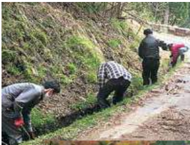
◀農業用水路の泥上げ
