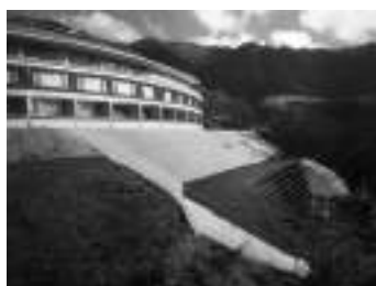
▲高原の宿水太くん法面復旧事業
