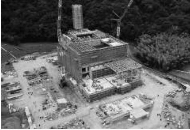
▲現在建設中の「リンピアいなば」
