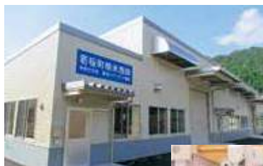
▲若桜町精米施設
