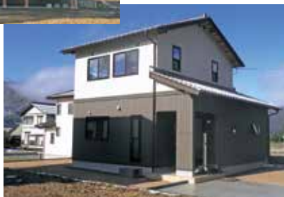
▲完成した若者向け町営住宅
