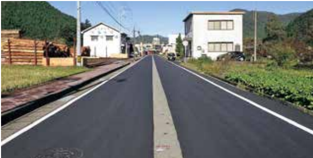
▲舗装改良工事 完成
