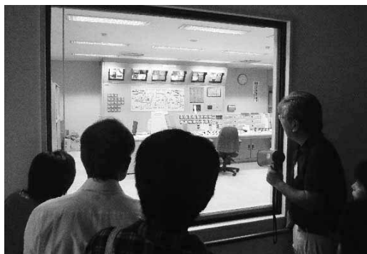
▲処理機械の制御室を視察
