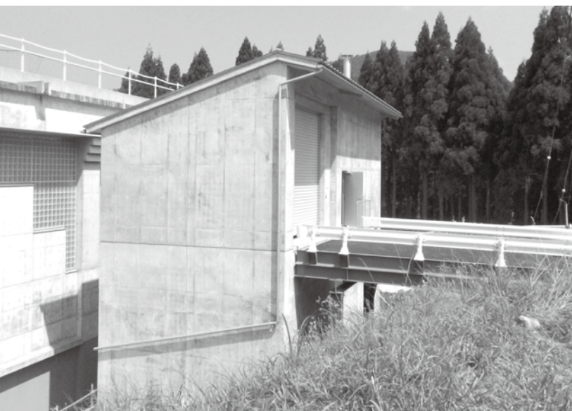
▲木質バイオマスボイラー外観
