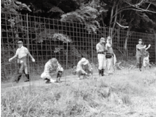
金網の取付作業
