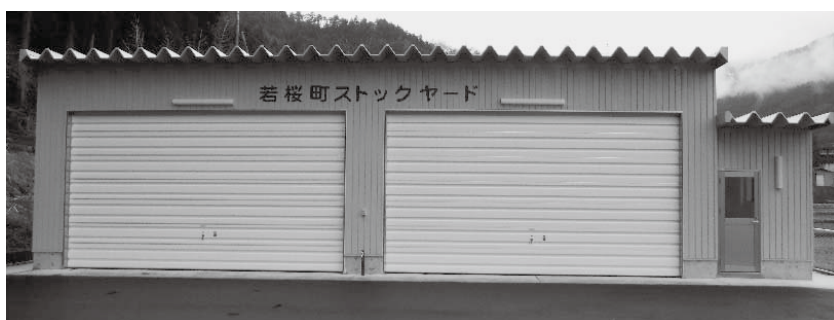
新しく完成したストックヤード
