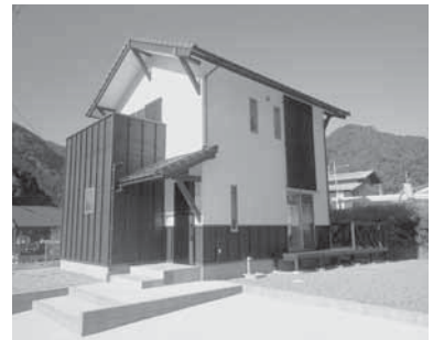
新しく建築された若者向け住宅①
