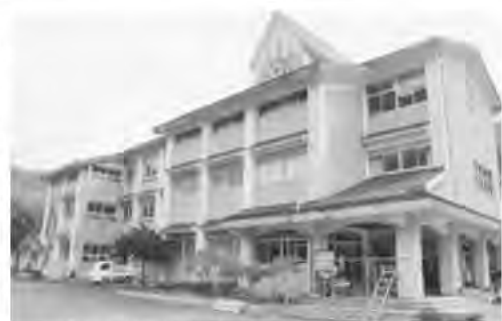
アロイ工業本格稼働(旧池田小学校)
