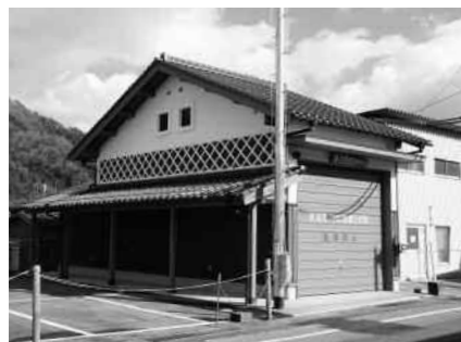
若桜町消防団第2分団消防車庫新築
