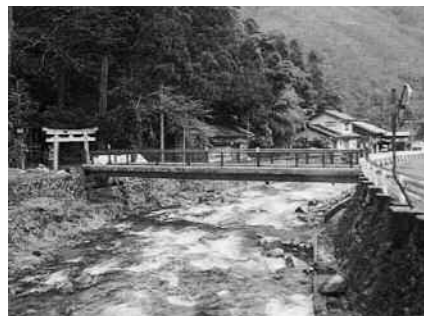
岩屋堂神社橋高欄取替
