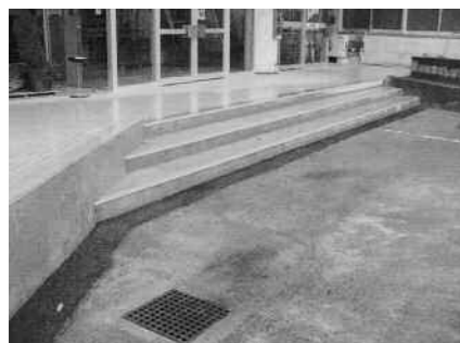
若桜町公民館改修
