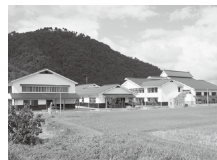
増築された校舎
