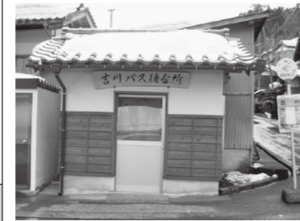
改修された吉川バス待合所
