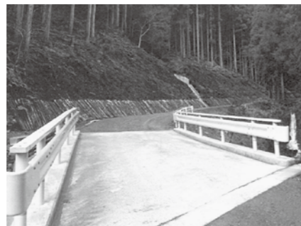
整備された林道屋堂羅線
