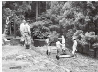
若桜簡水のろ過池及び流量調整施設
