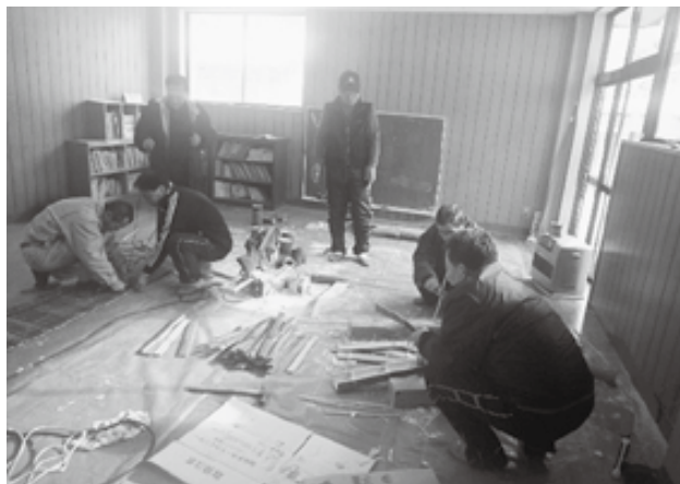
組み立て作業中
