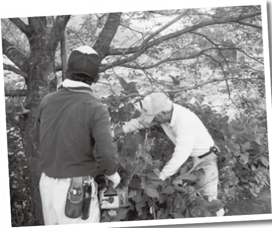
二人一組で撤去作業のようす
