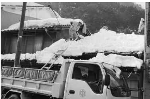
雪下ろしをする建設業者
