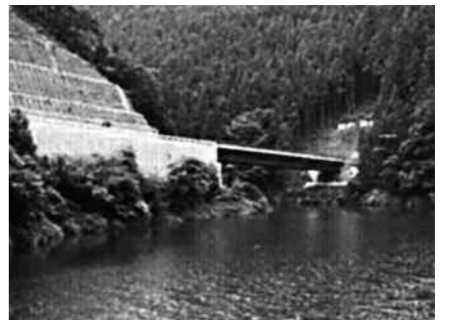
改良された国道482号の茗荷谷バイパス
