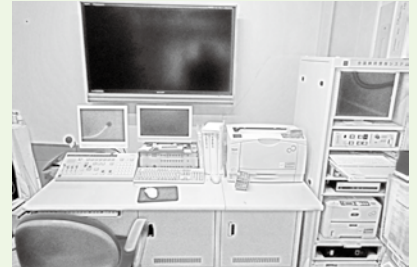
改修される防災無線親機
