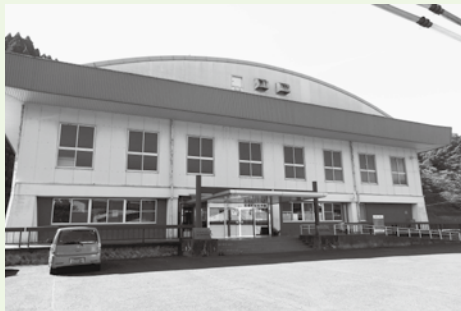
耐震工事される第1町民体育館
