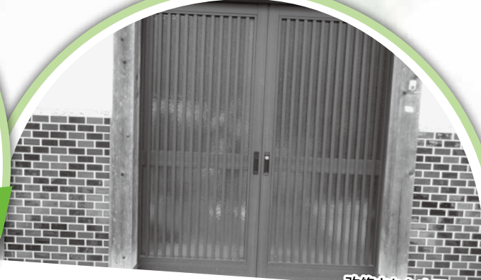
改修された玄関
