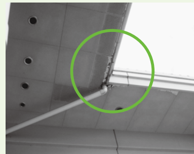
ドリーミーの屋根裏
