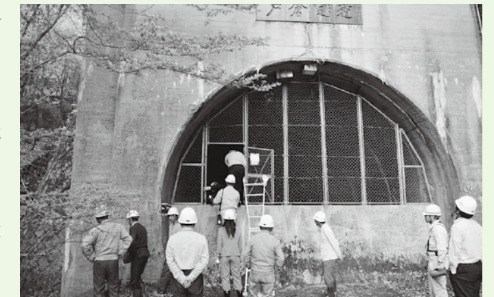
旧戸倉トンネルを視察の様子
