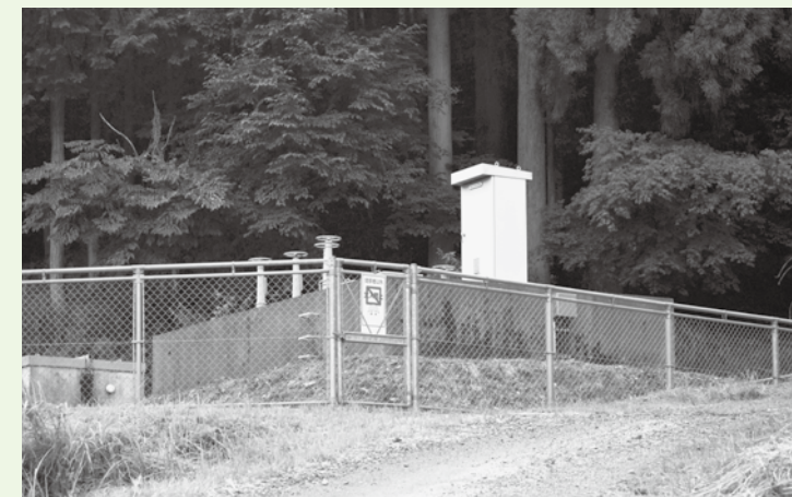
大野地区簡易水道配水池
