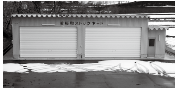
稼働が待たれるストックヤード
