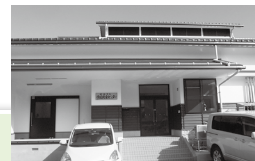
完成した若桜町給食センター
