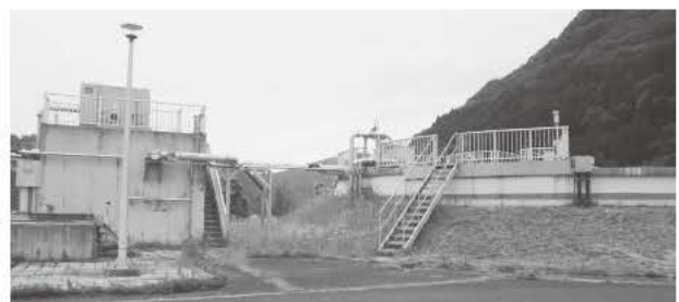
若桜下水道浄化センター
