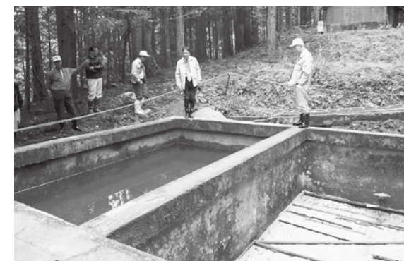
中原簡易水道施設の視察
