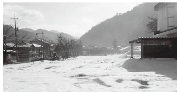
解体された旧若小校舎跡
