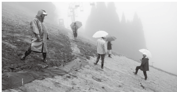
スノーピアゲレンデ修復工事現場
