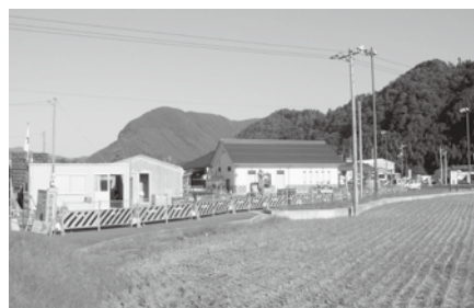
防災設備工事（道の駅内）
