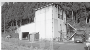
解体される旧塵芥処理場
