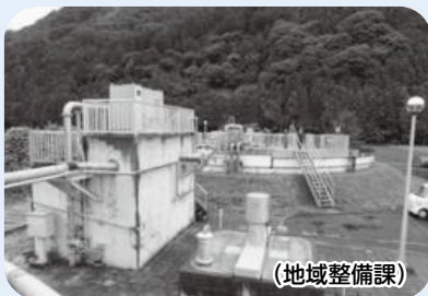
浄化センター
