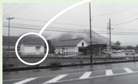
非常電源装置のある道の駅
