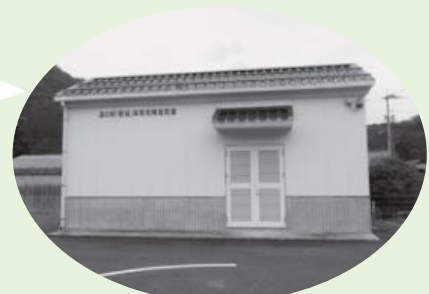
非常電源装置
