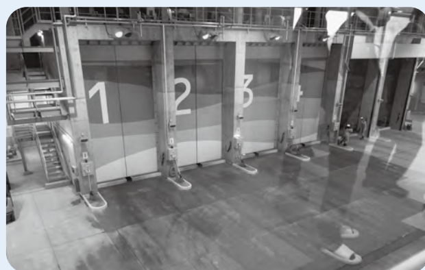
安全対策も考慮された広いスペースのゴミ搬入口
