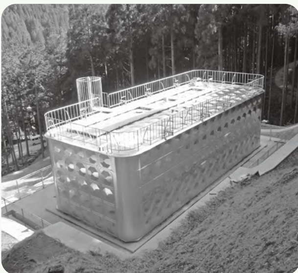
赤松簡易水道貯水槽
