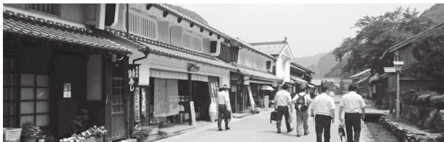
無電柱化されている若狭町熊川宿の街並み (2015年8月)
